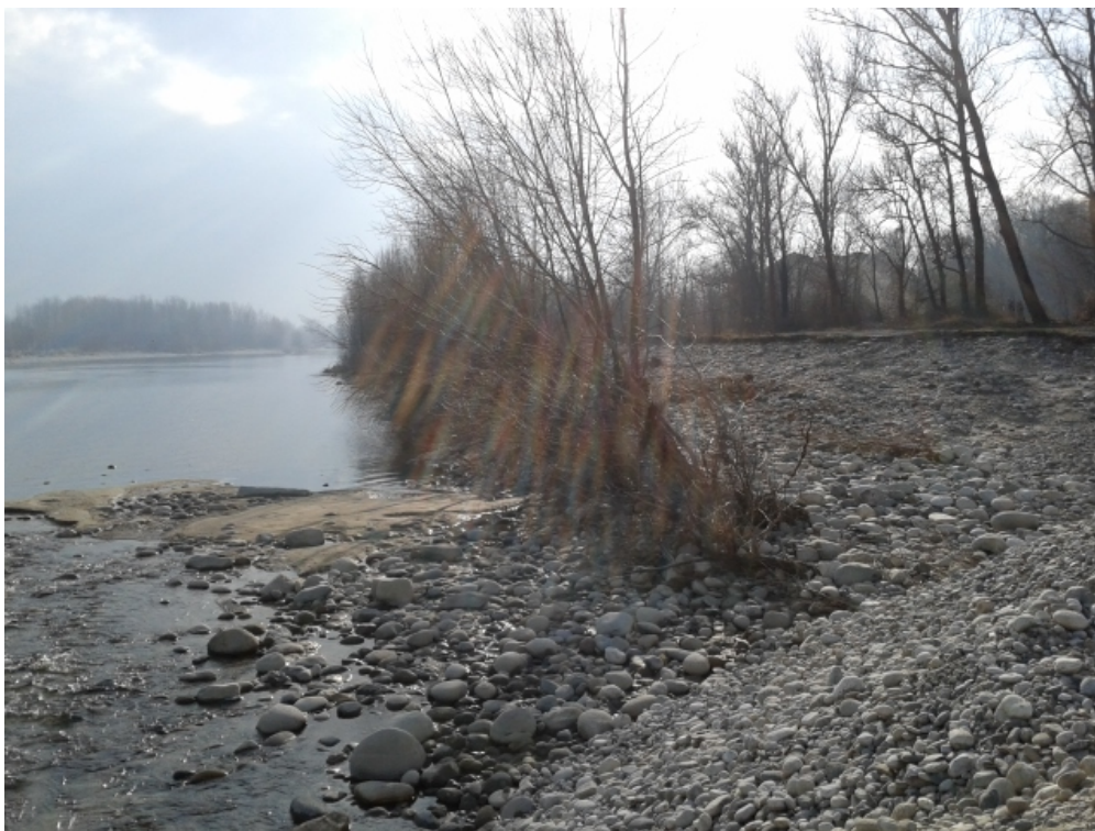
Fig.3 – Vista verso valle della sponda destra in erosione su cui realizzare le opere di difesa (14/01/2015)
