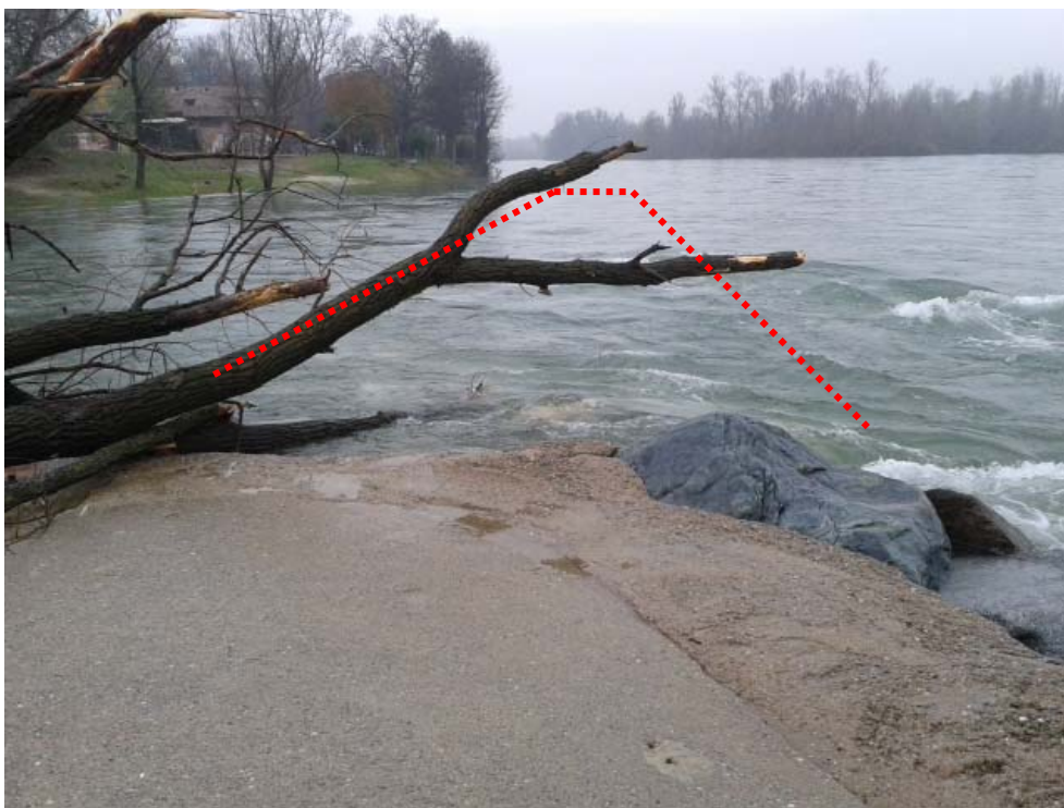
Fig.1– Vista del pennello rimasto con indicazione della porzione asportata (27/11/2014)
