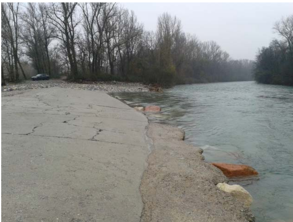
Fig.2 – Corpo del pennello danneggiato e vista dell'incile del naviglio inghiaiato (27/11/2014)
