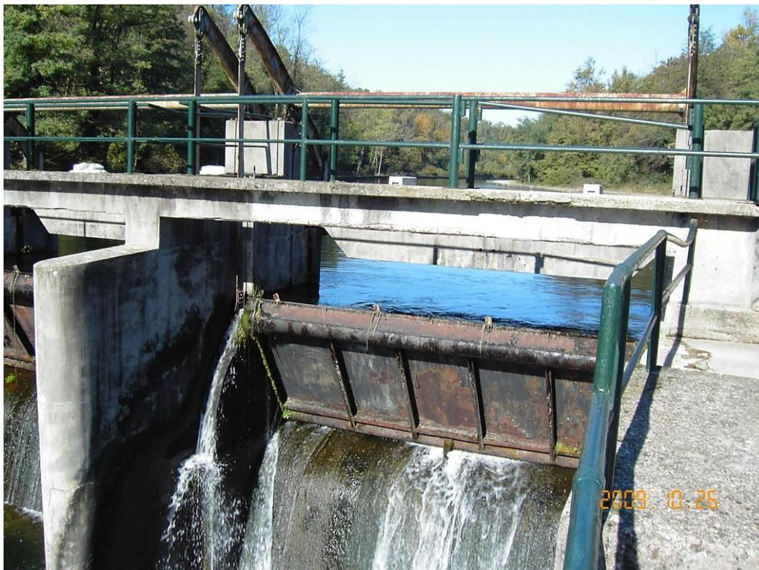
**Figura 4-14: Barraggio in calcestruzzo dotato di due paratoie autolivellanti a bilanciere**
