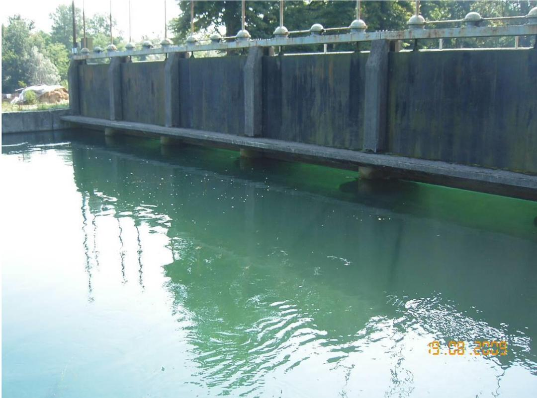
**Figura 4-10: paratoie piene dello sbarramento del canale di imbocco (canale di carico) della centrale**
