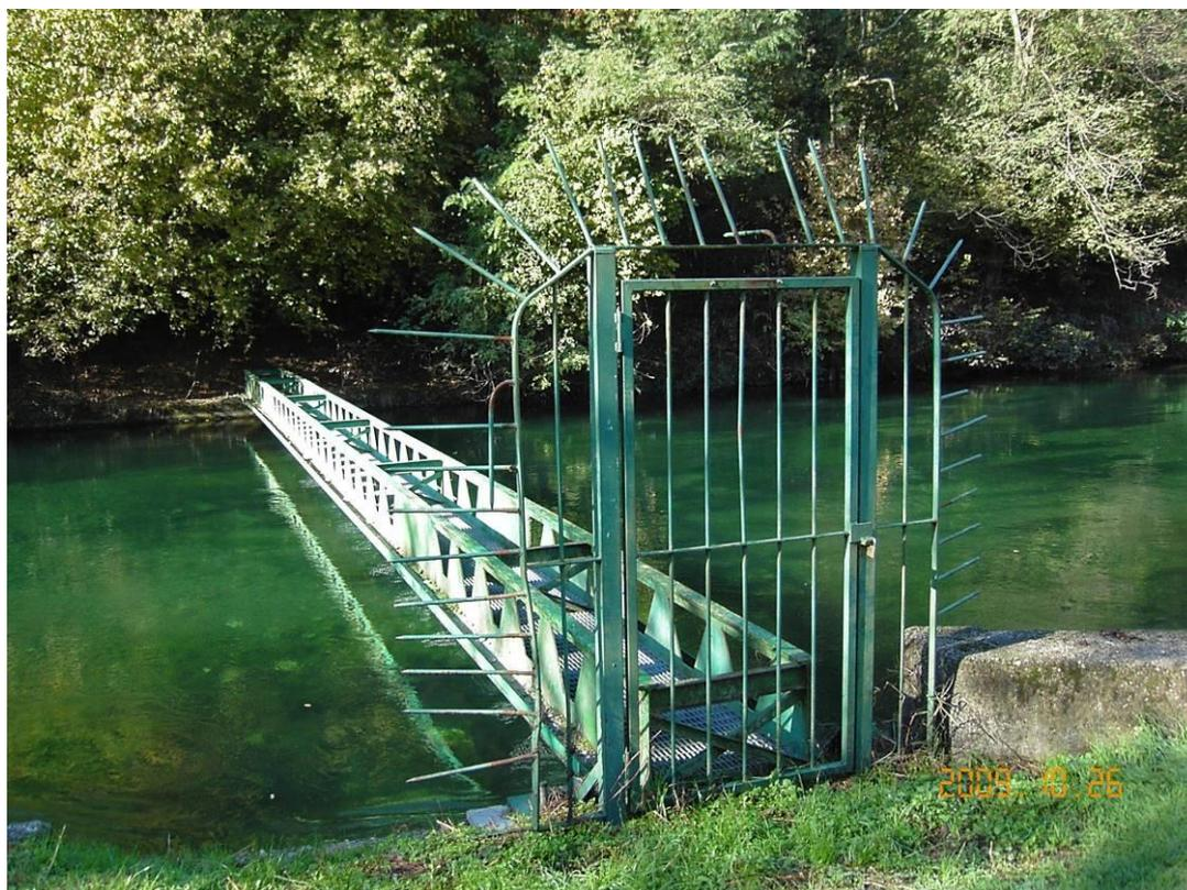
Figura 4-22: sbarramento a panconcelli tipo Poiree posto sul Langosco a valle del secondo scaricatore
