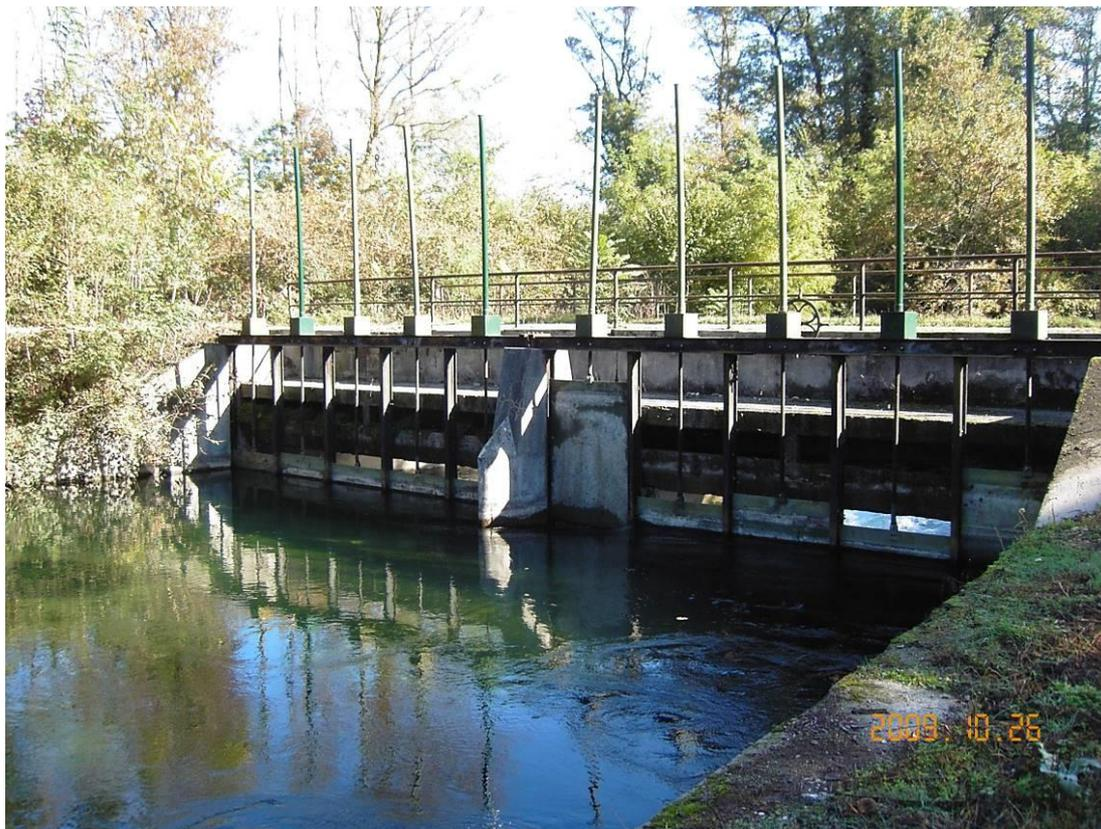
Figura 4-21: secondo sbarramento di scarico dotato di 10 paratoie piane
