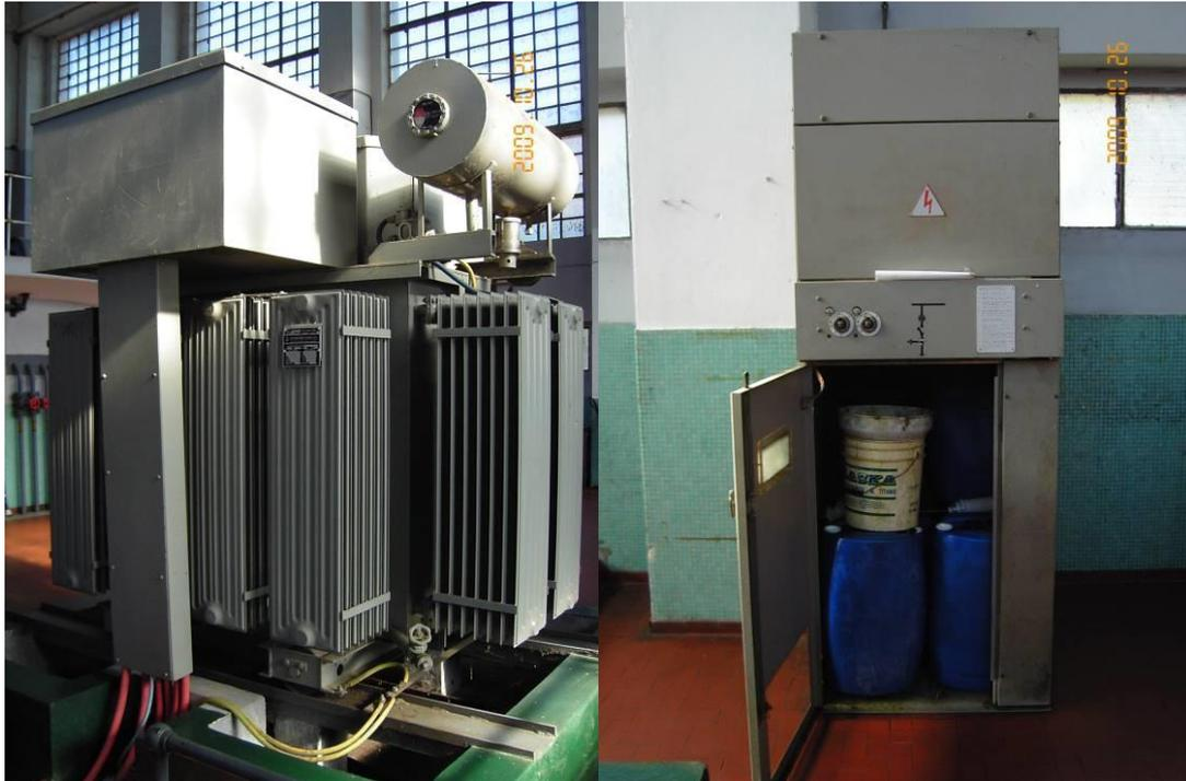
**Figura 4-19: trasformatore a olio da 2000 KVA e i fusti di oli esausti**
