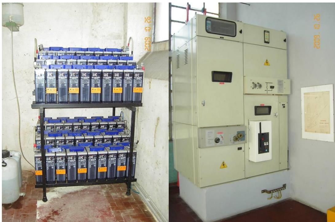
Figura 4-16: gruppo di batterie da 60 elementi e la cabina di consegna dell'energia
