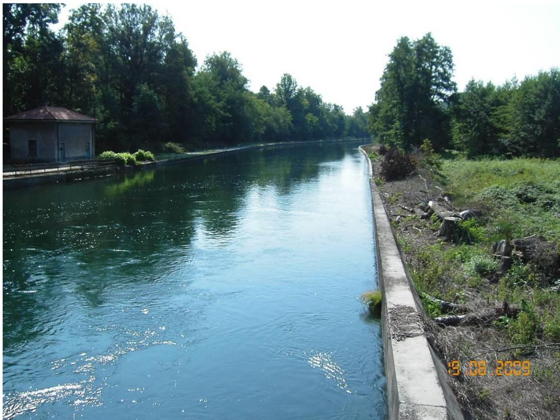
**Figura 4-11: canale di adduzione alla centrale lungo circa 1 km**
