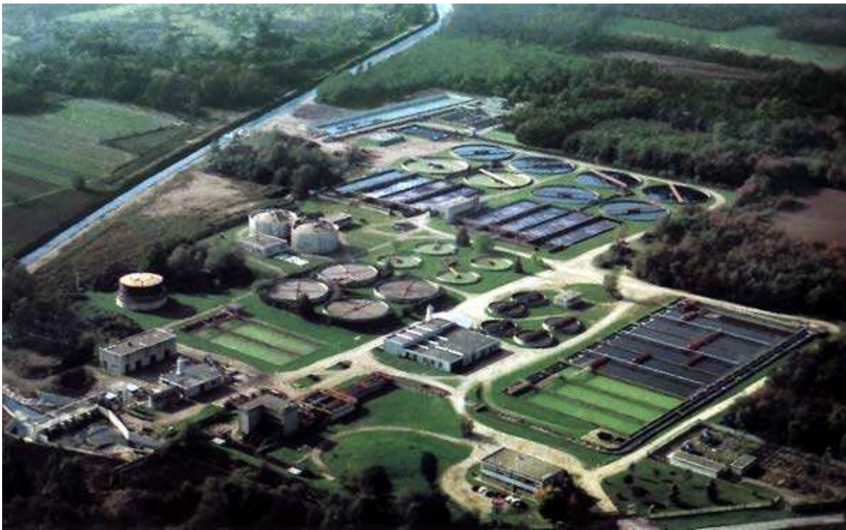
L'impianto di depurazione di Sant'Antonino: serve 27 comuni tra cui Busto e Gallarate e lo scalo di Malpensa (400.000 abitanti equivalenti). Al margine il Torrente Arno.
